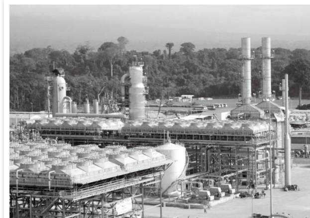
赤道ギニア LNGプラント
