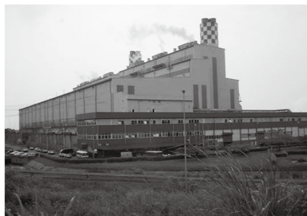
ナイジェリア・ラゴス火力発電所
