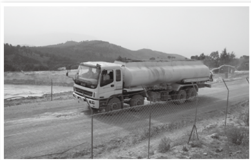
高速道路建設の現場
