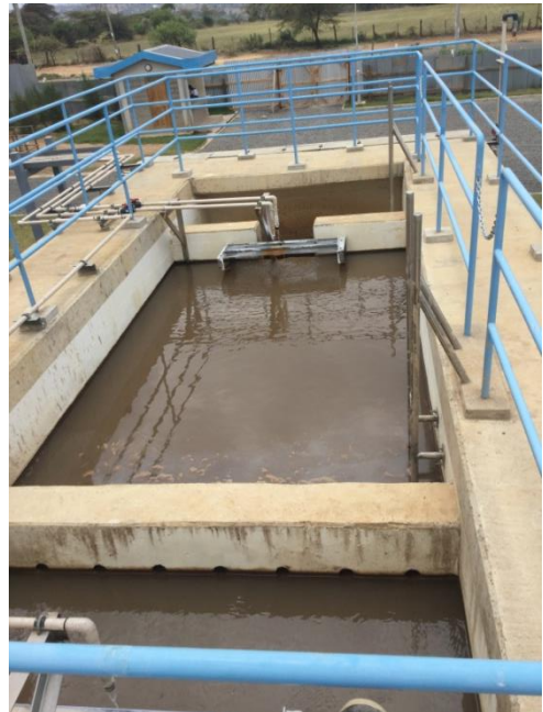
ポンプで河川から浄水場に送られてきた水です。この段階では濁っていますが、飲料に適するように浄化していきます。
