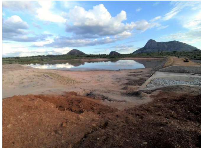
建設中のモデルため池（2017年1月26日）
