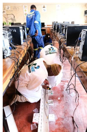
LANケーブル、ポート張替
