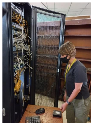
サーバールームのメンテナンスの様子
